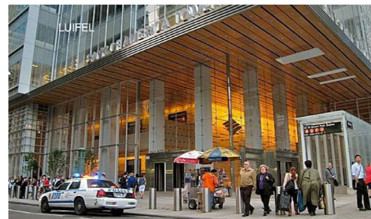
GEBOUWEN STAAN AAN DE STRAAT; ER BESTAAT INTERACTIE TUSSEN PLINT EN STRAAT
